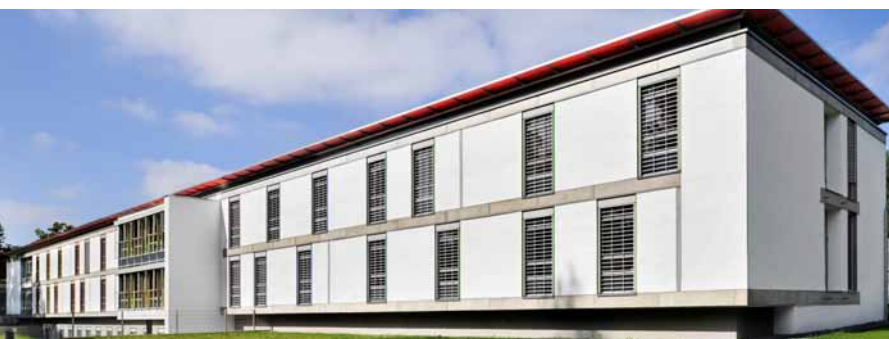
Außenansicht des neuen Hauses 16 der Forensik in Ansbach.
